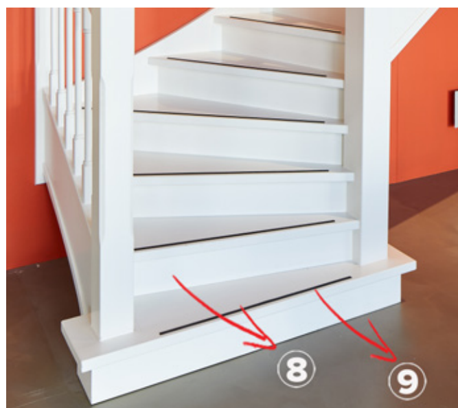
Afbeelding 3: Dichte trap met stootborden en slijtstrippen
