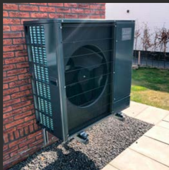
Een grindpakket om water op te vangen
